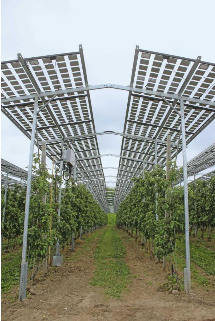
Die Ausrichtung der Module entscheidet auch über den Ertrag: Ostwest-Ausrichtung hat beinahe die doppelte Modulleistung im Vergleich zu reiner Südausrichtung. Dadurch bringt die Anlage etwa 40 % mehr Ertrag. Quelle: Helmut Süß [https://www.digitalmagazin.de/marken/blw/hauptthft/2022-51/energie/048\\_von-der-idee-zur-fertigen-agri-pv](https://www.digitalmagazin.de/marken/blw/hauptthft/2022-51/energie/048_von-der-idee-zur-fertigen-agri-pv)
