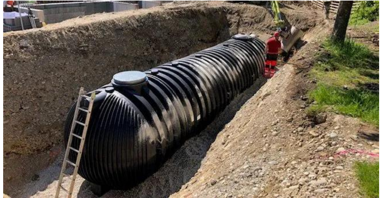
Großer Gegenwassertank: Regenwassernutzung – Schulhaus, Quelle: https://faparain.ch/
