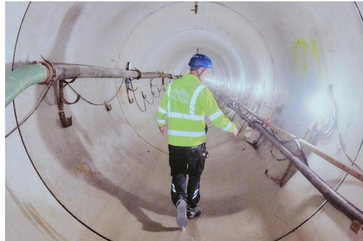
Als Reaktion auf extreme Regenfälle legte die Stadt Kopenhagen kilometerlange Tunnel an, die das Wasser zunächst zurückhalten und dann ins Meer oder in Kläranlagen leiten
