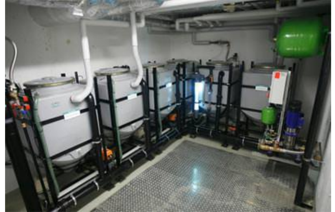
Forschungsanlage Grauwassernutzung mit Wärmerückgewinnung, Quelle: BauSites GmbH, https://www.baulinks.de/webplugin/2010/0019.php4
