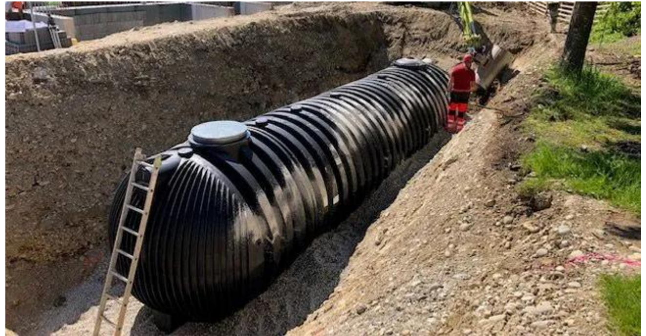
Großer Gegenwassertank: Regenwassernutzung – Schulhaus, Quelle: https://faparain.ch/
